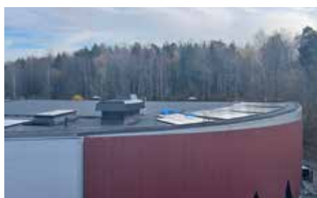
Sporthallens tak med solceller.
