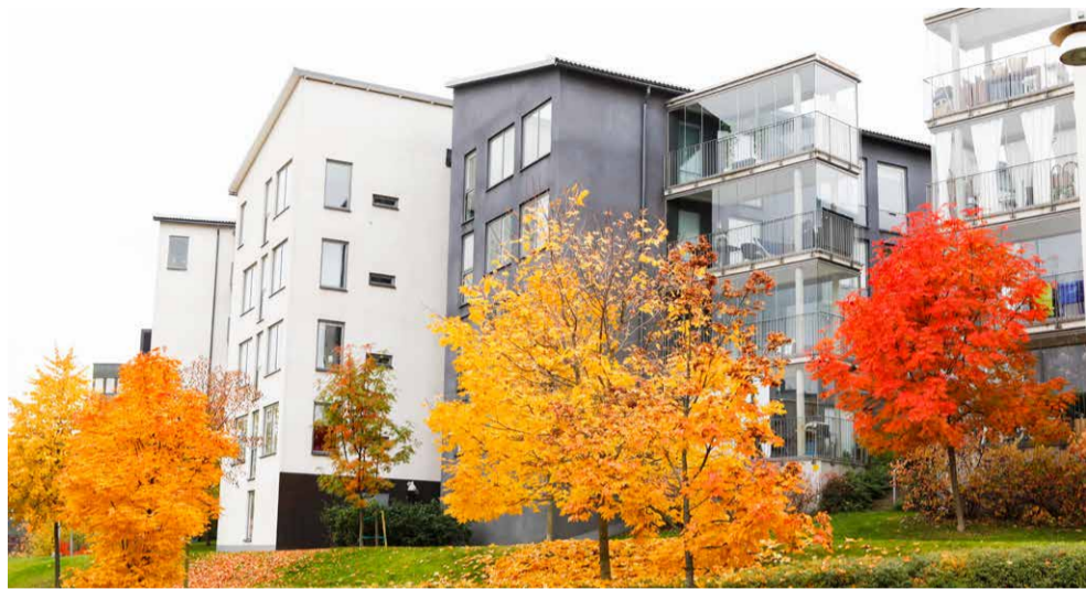
Var ska det byggas i kommunen efter 2020?
